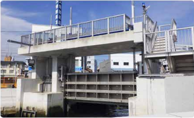
今治内港水門
