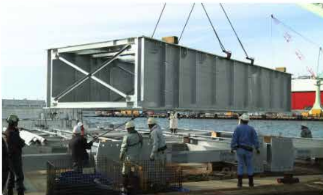
大西鉄工団地ヤード (バージ積み込み)
